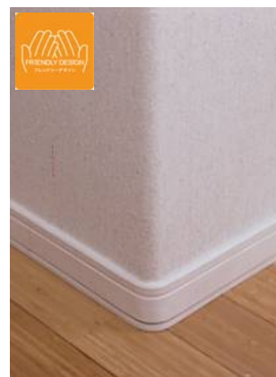
R壁 【特長】 壁の端部を丸め、優しさなど見た目の印象にも与える間仕切り壁
